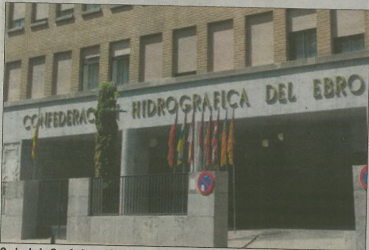
Sede de la Confederación Hidrográfica del Ebro, en Zaragoza. HDS
