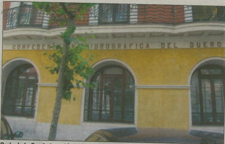
Sede de la Confederación Hidrográfica del Duero, en Valladolid. HDS
