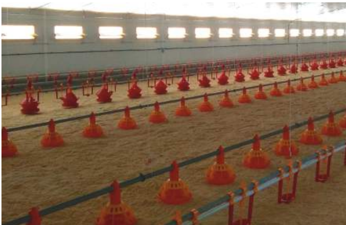
Nave avícola en la localidad de Casas de Sebastián Pérez
