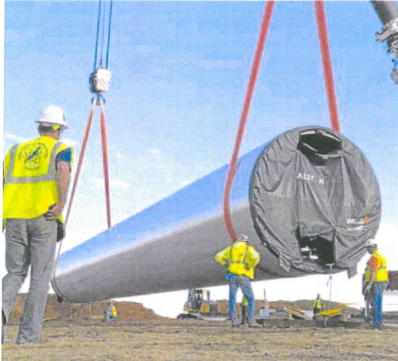
Trabajos de instalación de un aerogenerador. EL NORTE
