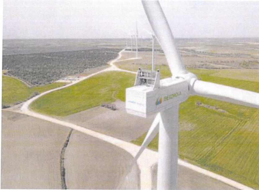
Complejo eólico Herrera II, de Iberdrola, en la provincia de Burgos. EL NORTE
