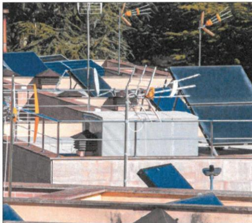
Instalación de placas solares en una vivienda de la capital. MARIO TEJEDOR
