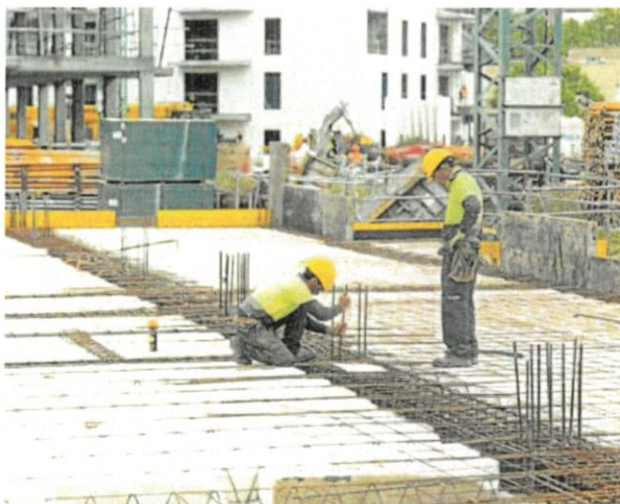
Construcción de viviendas de alquiler para jóvenes en el barrio de Parque Alameda. AIDA BARRIO
